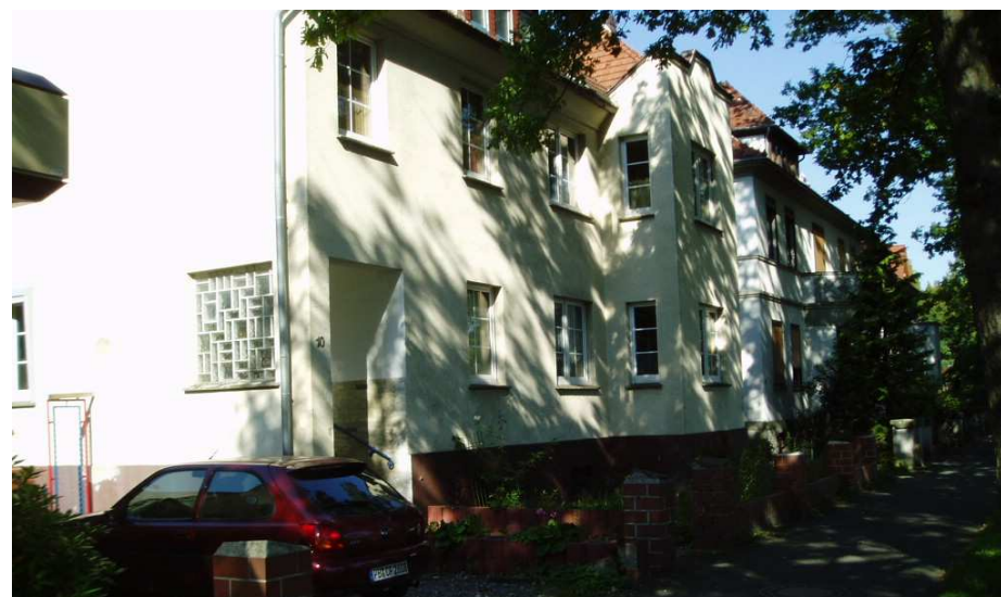
Drohender Verlust historischer Bausubstanz in der östlichen Allee
