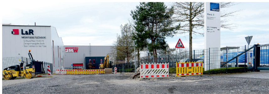
Im Bereich der Firma Heroal ist die alte Deckschicht der Heinz-Sallads-Straße bereits abgefräst worden.
