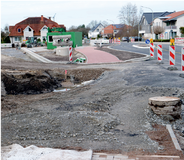
Neben ersten Bordanlagen in der Wendeschleife ist auf der Sennestraße auch der Fahrbahnteiler mit der Querungshilfe zu erkennen.
