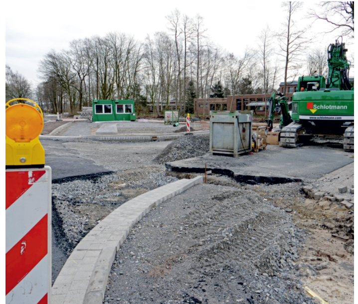
Blick in Richtung Nordosten auf die Baustelle der Buswendeschleife.
