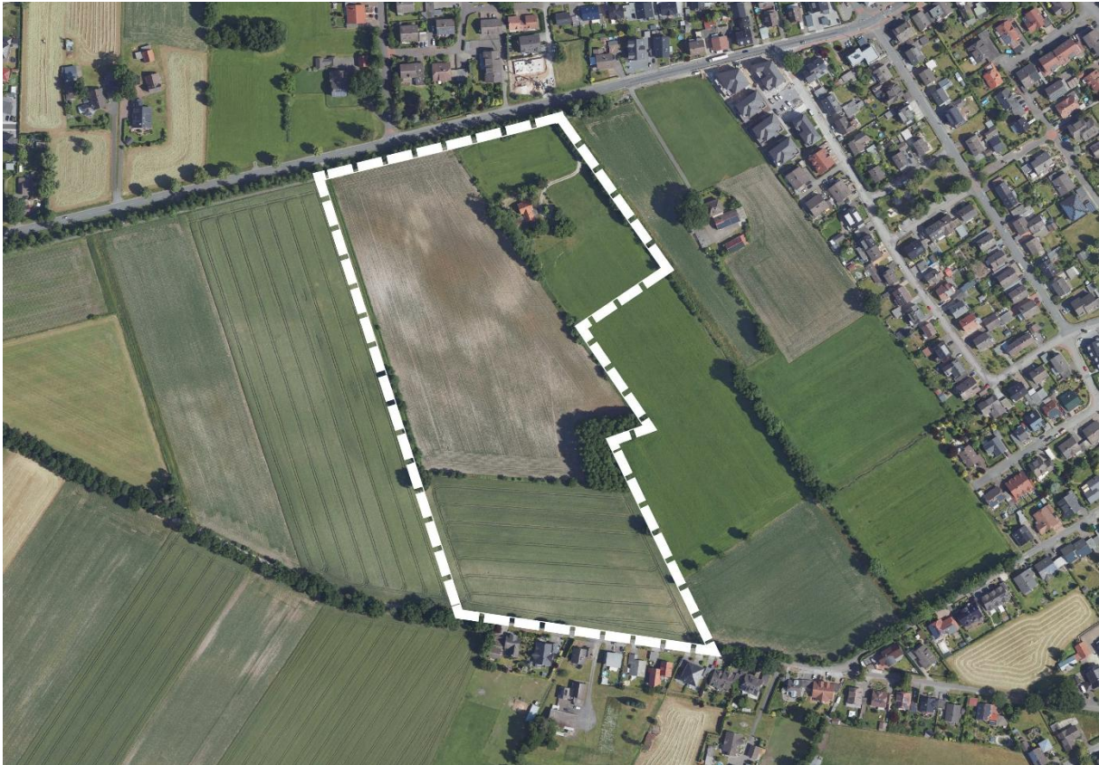
Abbildung 1: Geltungsbereich des Bebauungsplanes Nr. 62 „Rengerings Bruch I“ im Luftbild, ohne Maßstab (Quelle: Tim-Online NRW)
