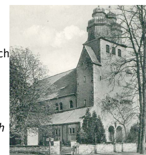
Foto: Bruchsteinmauern von 1820 zu den Straßenseiten des ehe- maligen Friedhofs Postkarte um 1950 Archiv Carsten Tegethoff
